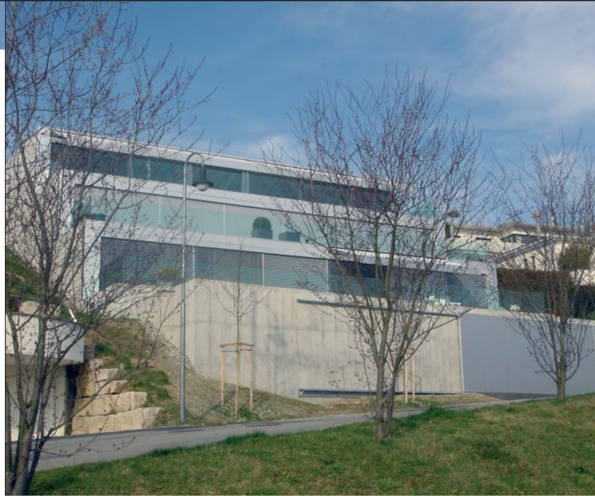
Aussenansicht Terrassenbau. Fassade in Sichtbeton und Metallverkleidung
