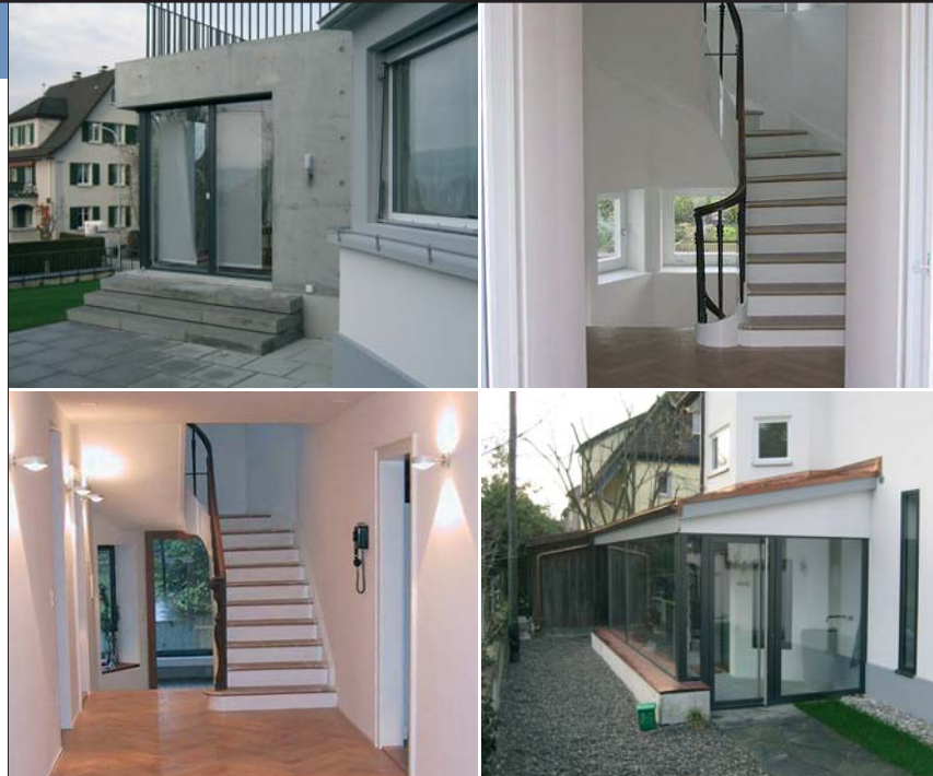
Aussenansicht Sichtbeton- und Wintergartenanbau, Innenansicht saniertes Treppenhaus
