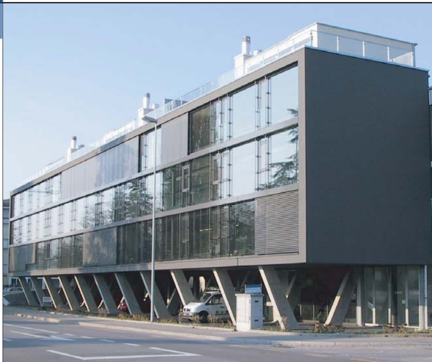
Fassade - Südost, Büro- und Wohtrakt
